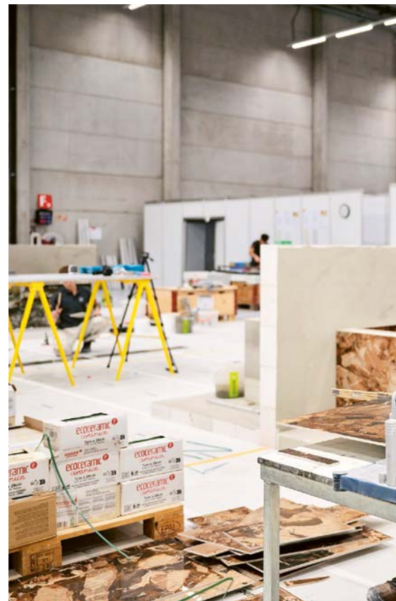
Plattenleger bei der Arbeit.
