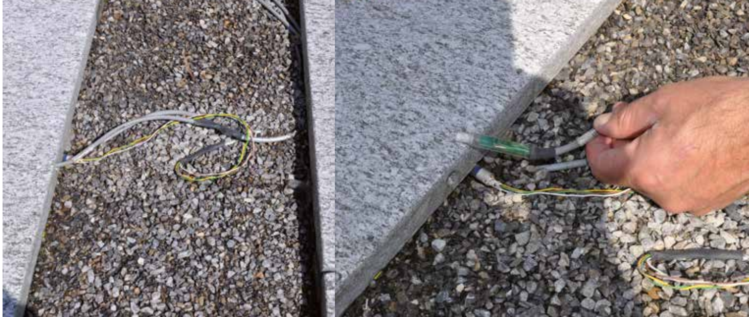
Messsonden für Temperatur und relative Feuchtigkeit liefern Daten für die laufende Auswertung.
