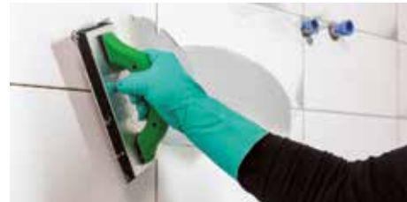
codex X-Fusion lässt sich sehr leicht, ähnlich einer zementären Fugenmasse, verarbeiten
