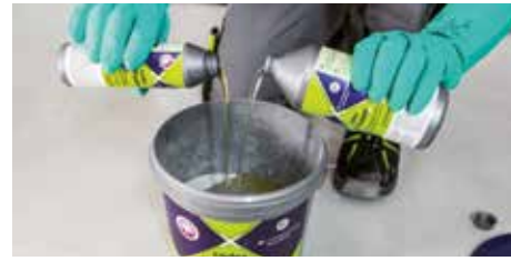
codex X-Fusion besteht aus drei Komponenten: Harz, Härter, Farbsand. Beim Anmischen ist keine bestimmte Reihenfolge der Komponenten zu beachten.
