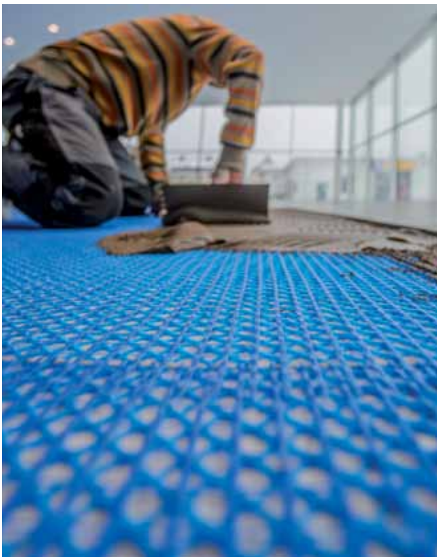
Blanke PERMAT beim Verlegen La pose de Blanke PERMAT
