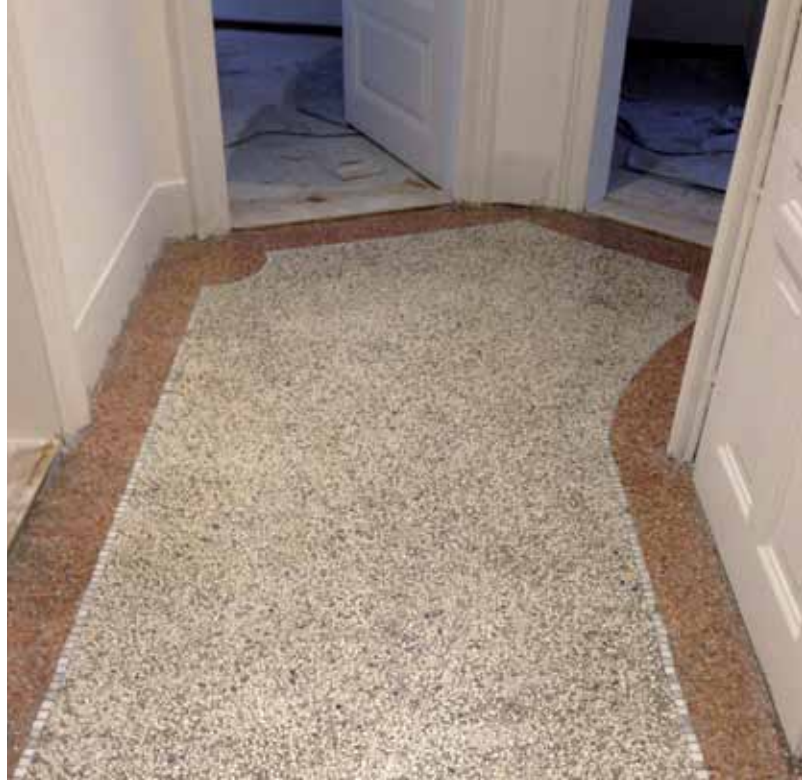
Sol de la cuisine avant et après la restauration (Photos: Silvio Boschian)
