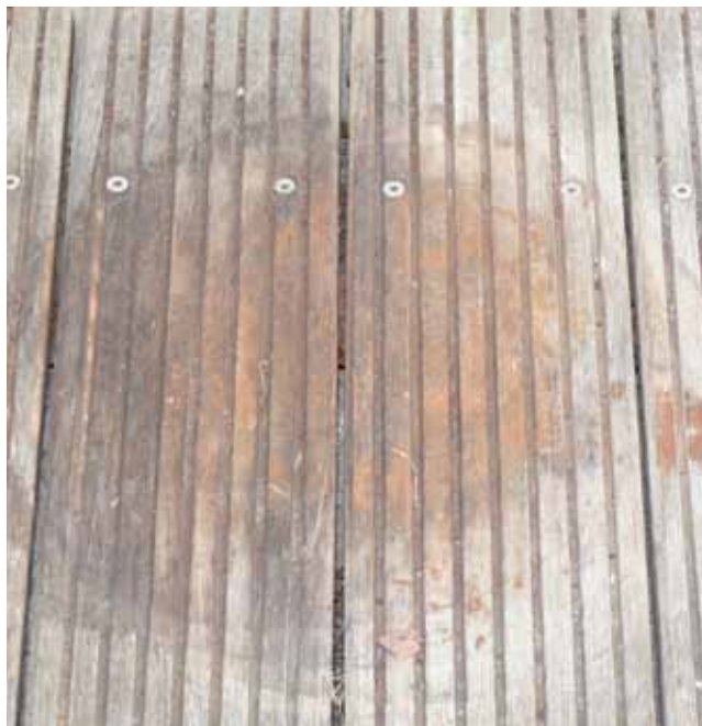
Farbunterschiede sind ein Nachteil von Holzbelägen. Les différences de couleurs sont un inconvénient du bois.
