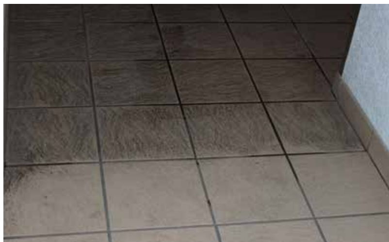
Industrieboden vor (hinten) und nach sachgemässer Reinigung. Sol industriel avant (à l'arrière) et après un nettoyage adapté.
