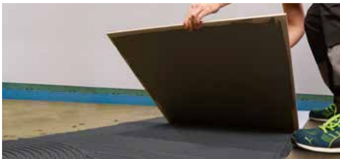
Codex Power RX 11 Outdoor ist während rund 60 Minuten verarbeitbar und nach 6 Stunden fugen- und begehrbar.
