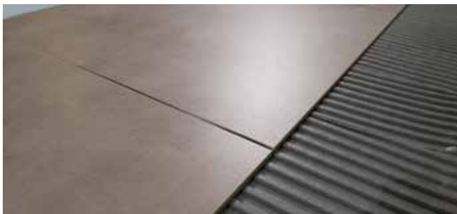
Platten bis 120 Zentimeter Kantenlänge problemlos im Aussenbereich verlegen.
