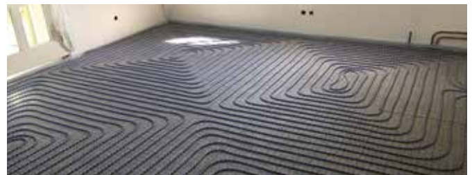
Die verlegten Heizrohre beim System ab 14 mm
