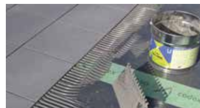
Feinsteinzeugplatte verlegt mit codex Fliesopur auf Abdichtungsbahn UZIN RR 185.
