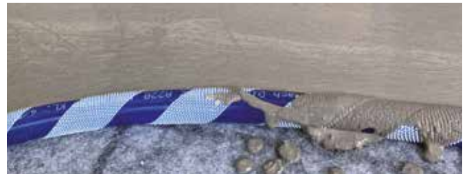
Eingießen des Blanke SF FILLER
