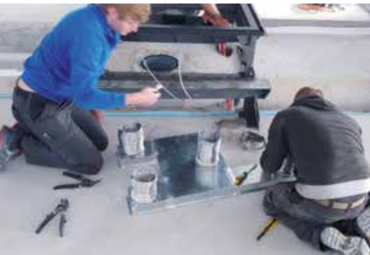
... Metallarbeiten für ein Cheminée.
