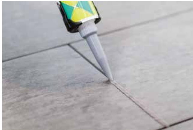
Codex X-Care ist in der Kartusche erhältlich und kann entsprechend gespritzt und abgezogen werden. Dieses Verfahren eignet sich besonders gut für die Verfugung von grossformatigen Platten.
