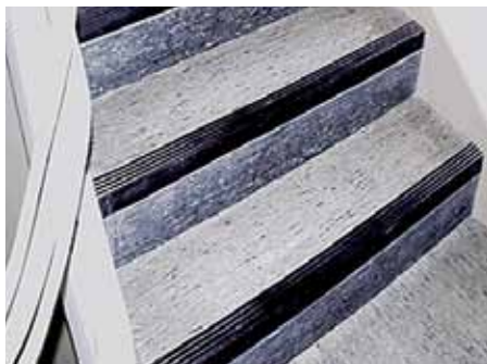
Heikel: Treppenhaus mit Linoleum.
